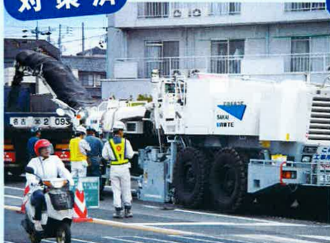
■粉じん対策をした施工
